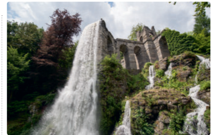
▲ Stürmische Wasserspiele: Äquodukt im Bergpark Wilhelmshöhe
